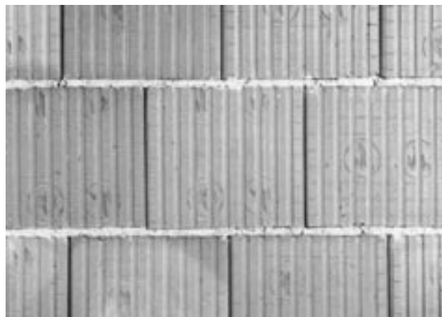
Obr. 20-2 Zdivo bez viditelně promaltovaných styčných spár
