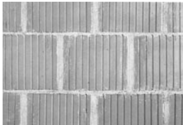
Obr. 20-1 Zdivo s viditelně promaltovanými styčnými spárkami
