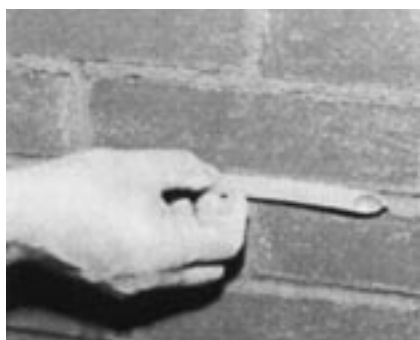
Obr. 11-2 Úprava spáry pomocí měkké gumové hadice
