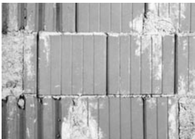
Obr. 11-4 Vyspravení povrchu zdiva před omítáním
