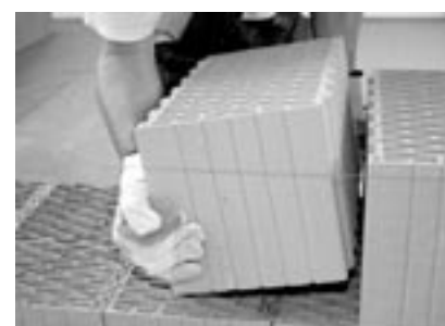
Obr. 10-3 Zdění z broušených cihel
