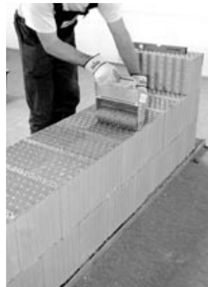
Obr. 10-4 Nanášení malty válcem
